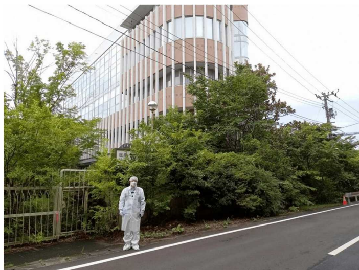
上の写真のとおり、双葉病院正門前にある「医療法人 博文会双葉病院」の看板が木々に覆われて大半が見えなくなっており、また正門の内部も木々が繁茂している。
